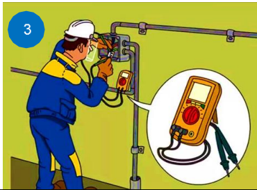
3. Verificar la ausencia de tensión.
